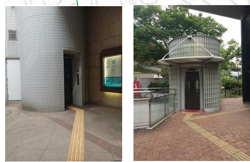
地上につながるエレベーター
